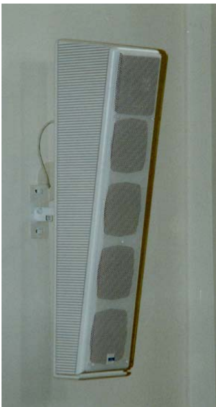
Ansicht Kanzelwand: 4 Lautsprecher für Schiff; 2 Lautsprecher für Emporen
