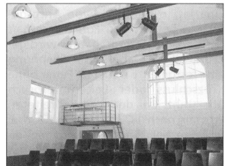
Bild 3 Die fertig renovierte Grabenhalle. Für eine ausgewogene Raumakustik sorgen an den Wänden als schallreflektierende Fläche eine Verkleidung aus Diamond-Platten und die zur Schallabsorption an der Decke montierten Lochplatten.
